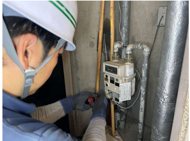
端末設置作業中の組合従業員
