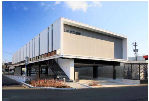
本部があるLPガス会館
