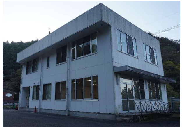
草創期から集中監視システムに取り組む株式会社窪川ガス
