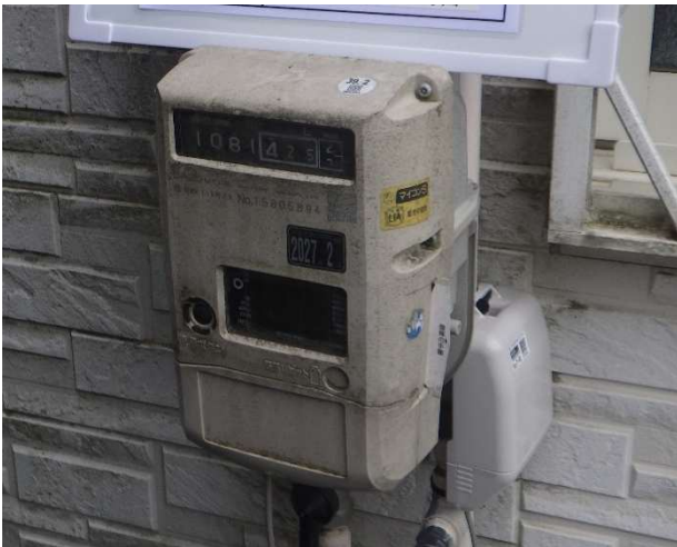
L PWA通信端末の設置工事は自社で行った
