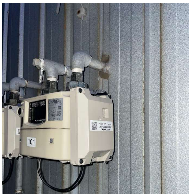
L PWA端末の設置工事は冬前に1カ月で完了させた
