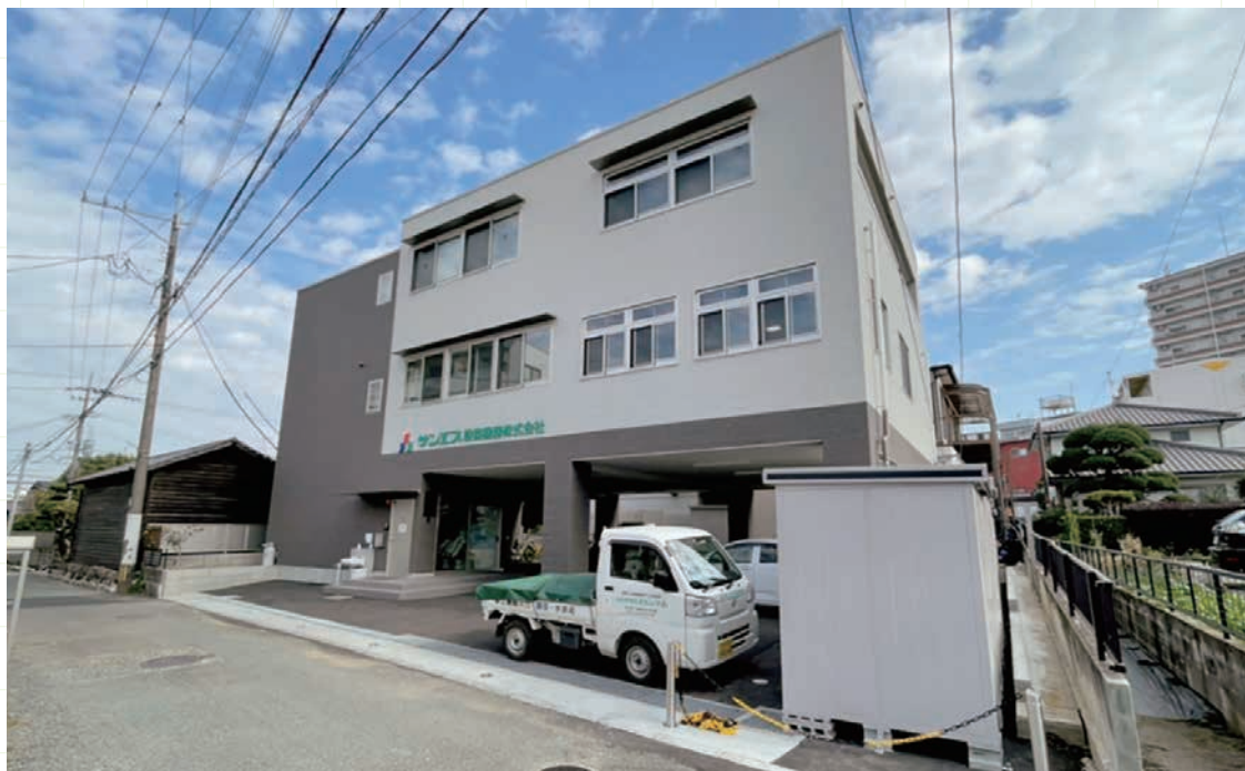
サンエス設備機器外観
