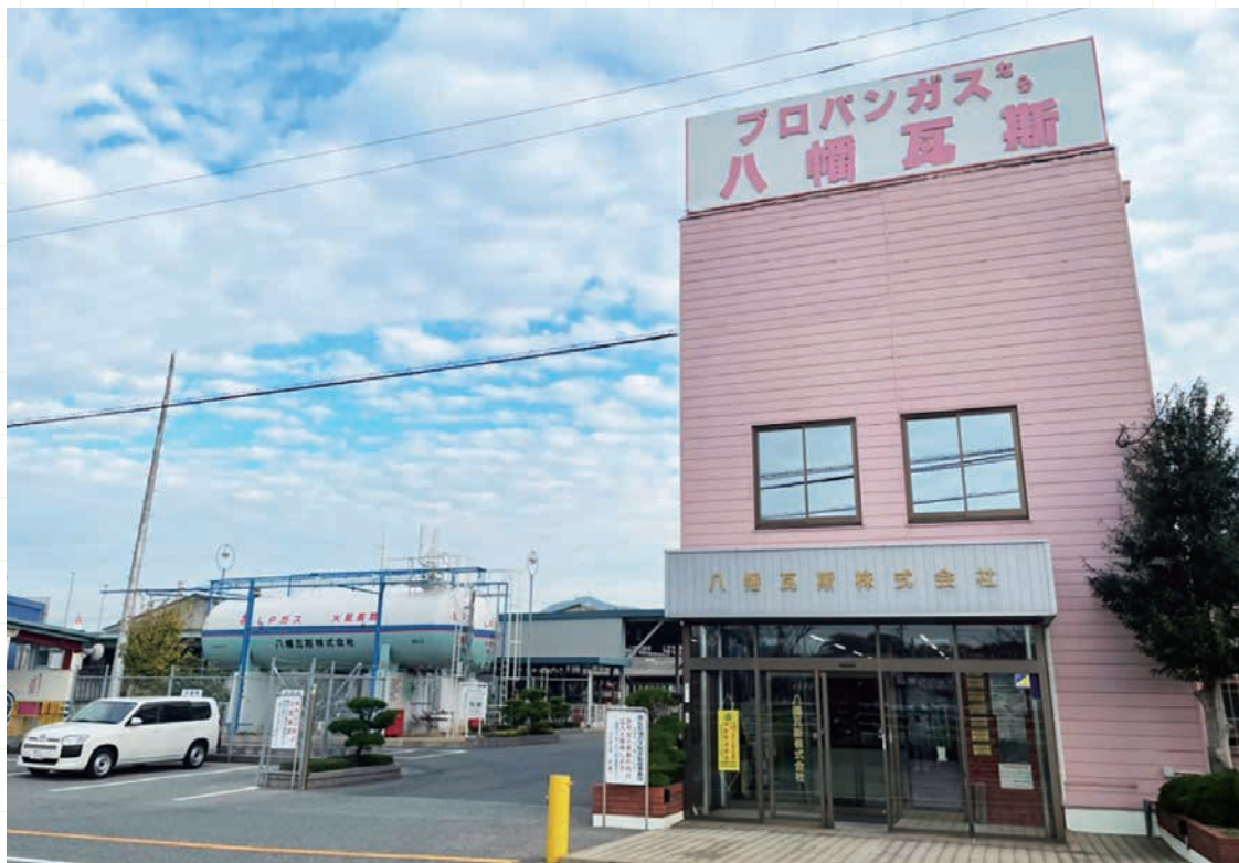
八幡液化ガス外観
