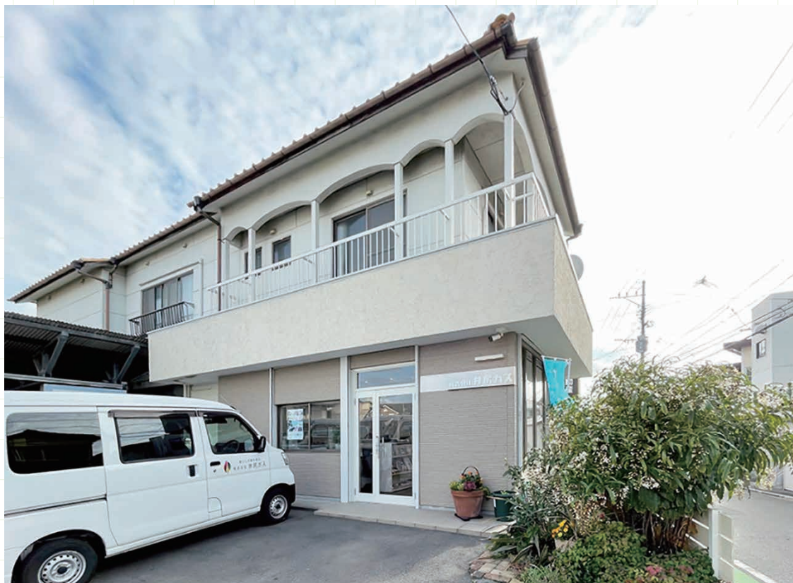
井尻ガス外観
