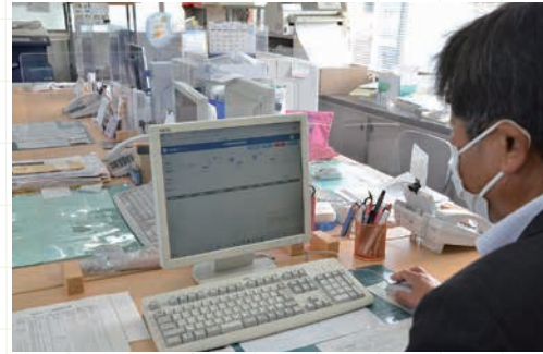
集中監視システム
