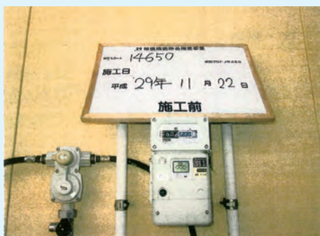
既設メータの更新
