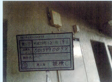
バルク設備の無線機設置
